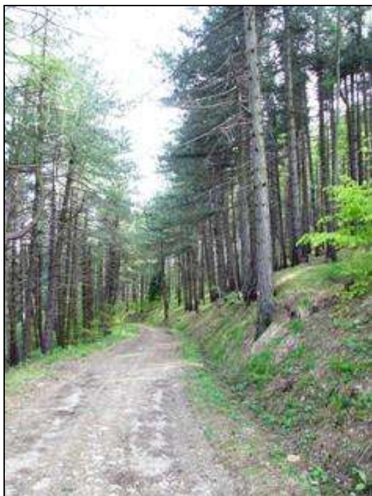
Figura 13: Strada di Costa d'Alpe;
