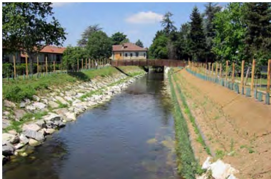
Figura 31 - Un esempio di opera di ingegneria naturalistica: le basi per una copertura diffusa di salici per il consolidamento delle sponde di un corso d'acqua.
