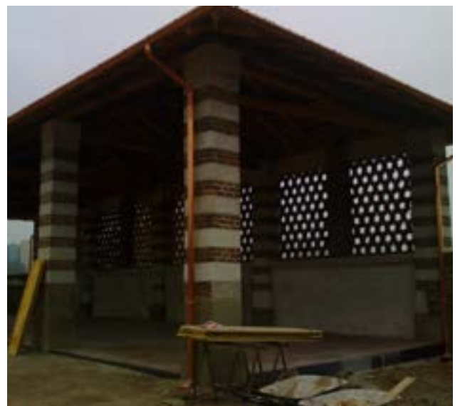
Serie di fotografie che illustrano alcune delle fasi di messa in sicurezza e ripristino della tettoia
