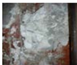
3. esempio di efflorescenza salina
