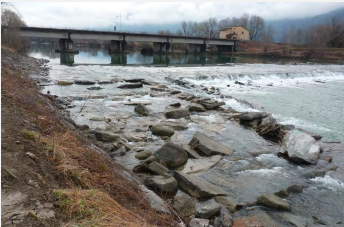
Figura 11: Rampa in pietrame per la risalita dei pesci.
