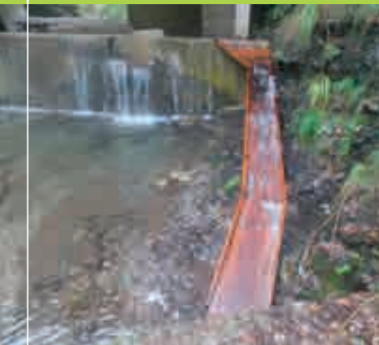
Rampa in legno per la risalita dei gamberi
