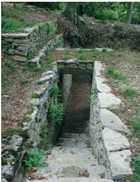
Ingresso della Trincea n°3
