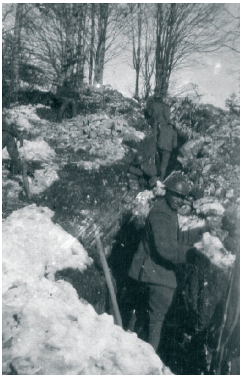
Costruzione trincea al Barco dei Montoni
