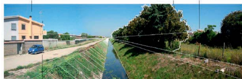
tratto discontinuo di strada lungocanale
