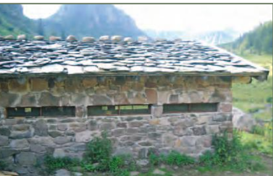
Silter di Valgabbia , Berzo Inferiore parte adibita al deposito del latte copertura con "piöde" locali
