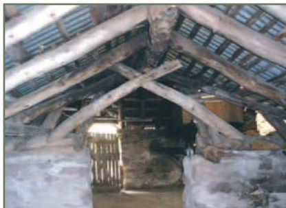
Malga Craper di Valdaione , Bienno: particolare della capriata
