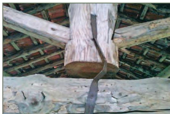
Particolare della " staffa " che raccorda il " monaco " alla " catena "
