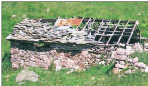
Casera di Valgabbia , Berzo Inferiore: orditura del tetto
