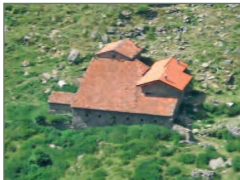
Valbrescianina e Cigoletto, Bovegno: copertura in coppi
