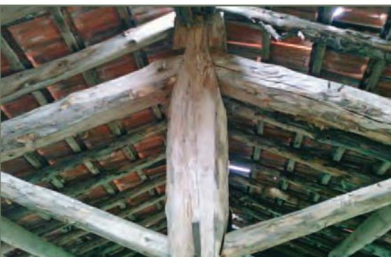
Particolare del " monaco " e dell'innesto dei " puntoni " e della " saetta "
