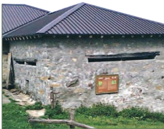
Malga Pianazzo , Esine: finestre orizzontali per l'aerazione del deposito del latte
