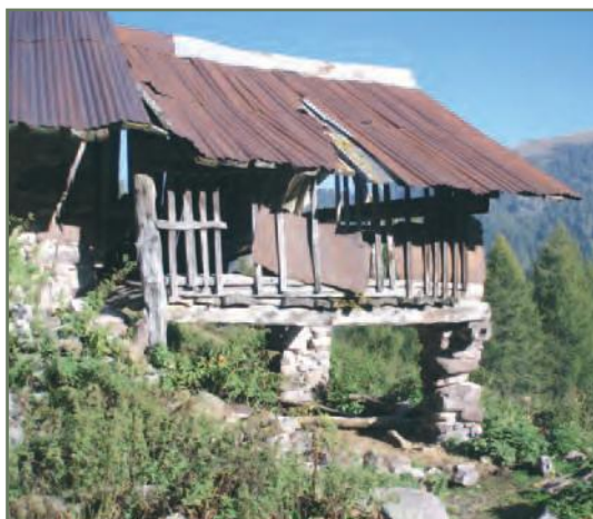
Silter di Gianico , Gianico: il ballatoio adibito a deposito del latte
