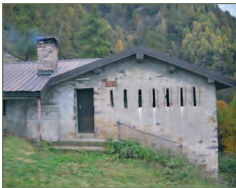
Dosso Rognone , Esine: finestrelle verticali per l'aerazione del locale adibito al deposito del latte
