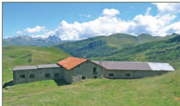
Malga Stabil Fiorito , Bovegno copertura mista in lamiera, coppi e soletta in calcestruzzo
