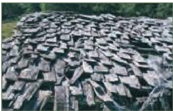
Valbonina , Berzo Inferiore: particolare della copertura in scandole
