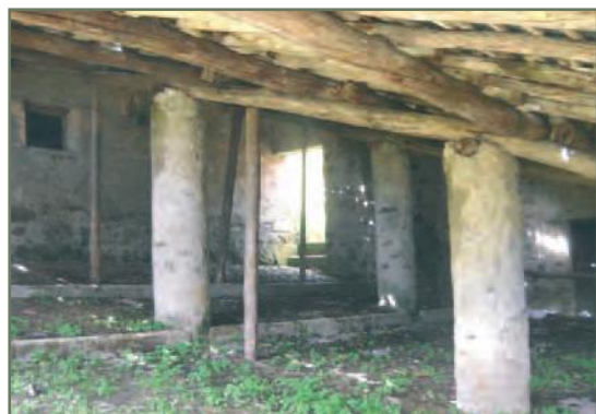
Malga Vestone , Bovegno particolare delle colonne di sostegno del tetto
