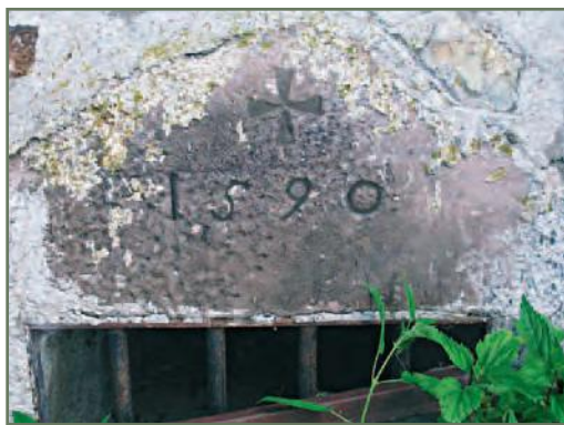
Malga Rondeneto , Gianico: architrave della finestra del "silter"; soprastante la data una croce in stile gotico
