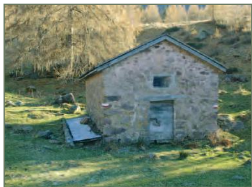
Malga Rosselletto , Esine: struttura del "silter"
