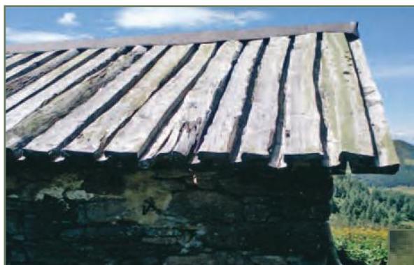
Val di Frà, Esine: copertura con “canalotti”
