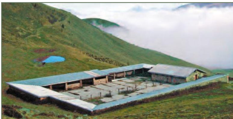
Malga Paglia , Gianico: edificio per il ricovero notturno del bestiame, munito di sala mungitura inutilizzata in quanto risulta più funzionale il sistema della mungitura mobile
