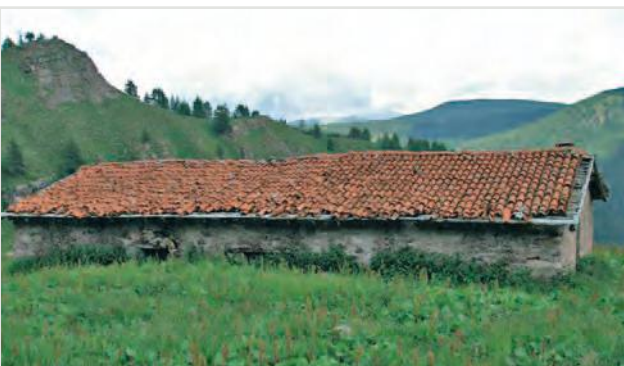
Valbrescianina e Cigoletto, Bovegno: copertura in coppi
