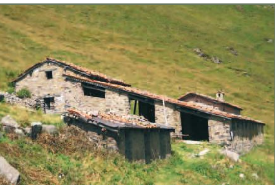
Malga Vestone , Bovegno lo stallone segue la pendenza del terreno
