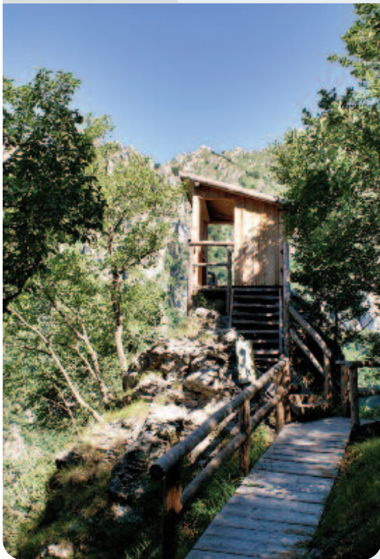
Capanno di avvistamento
